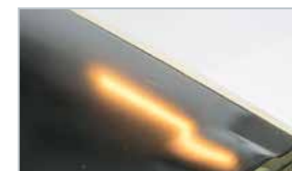
Rychlé dokončení pomocí ohřevu
